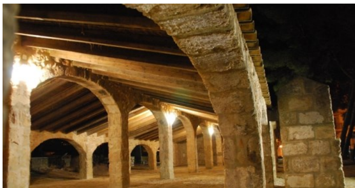
Ruirau : bâtiment en pierres pour le séchage du raisin
