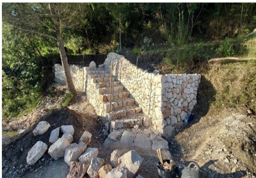
Construction restaurée avec la technique de la pierre sèche
